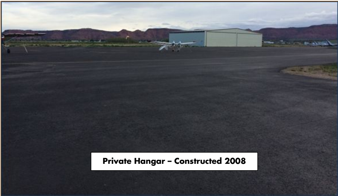
Hangar 1 & Mobile Fueler
